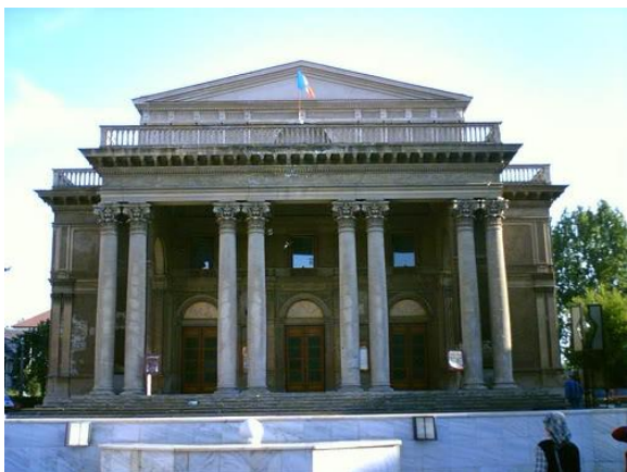
Figura 3.37. Casa de Cultură
